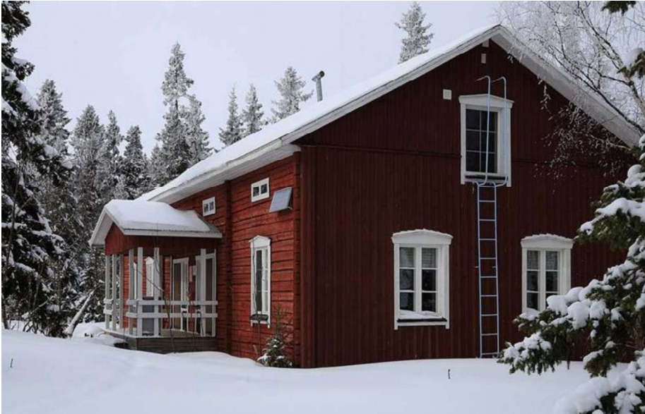
Kuva 8. Montajan leirikeskuksen päärakennus
