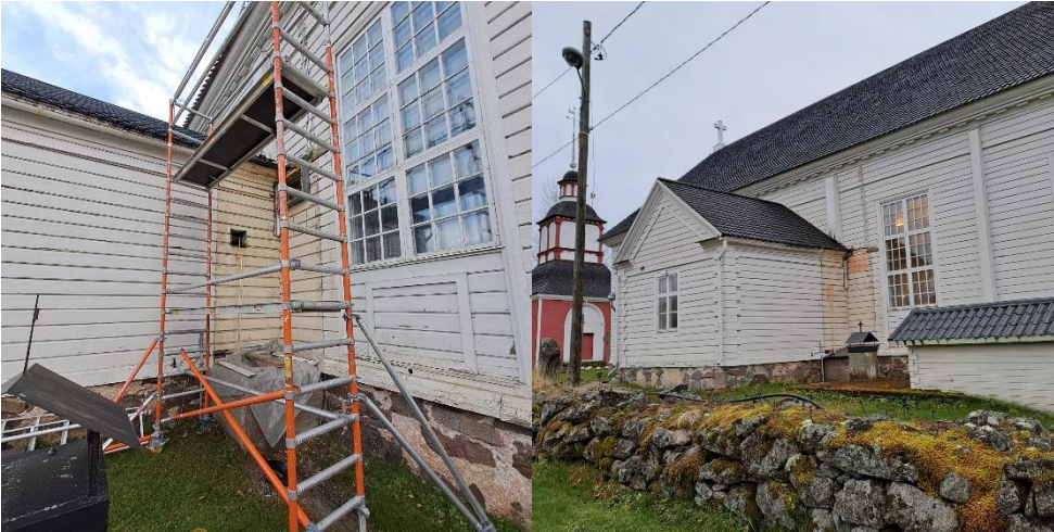
Vanhan ilmakanavan poisto.
