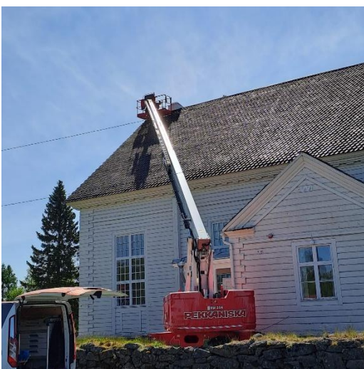
Uusien ristien asennus kesällä 2025
