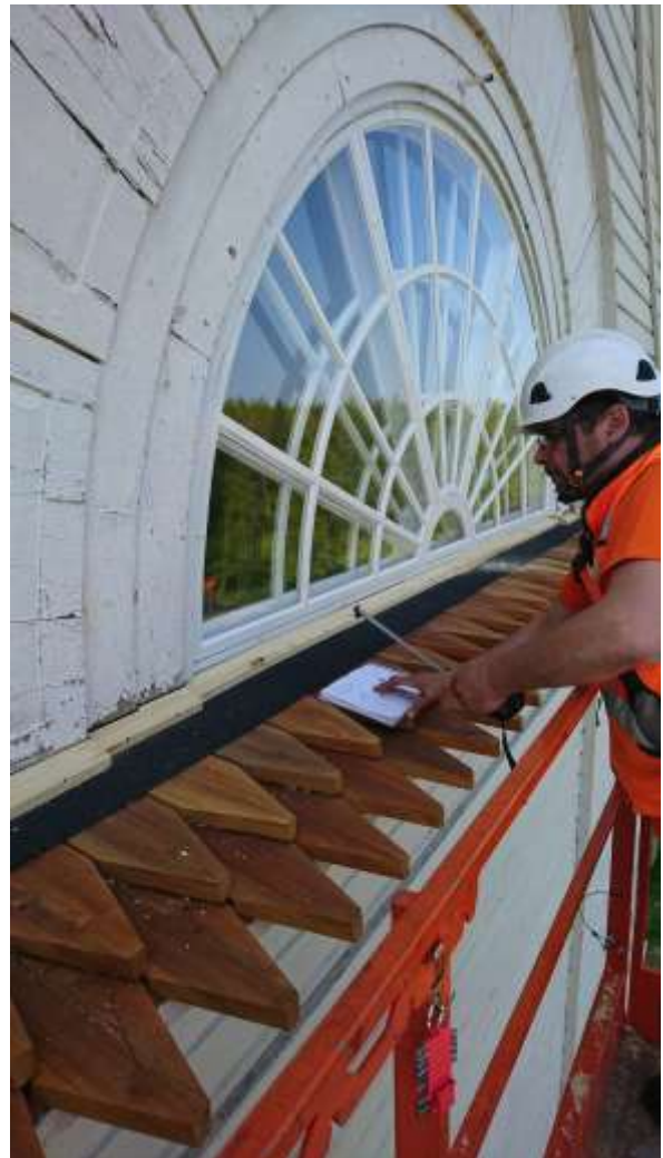
Ikkuna asennettu, paanut tervattu, pellitysten pohjatyöt tehty, pellitysten mittaus menossa. 15.6.2023 kuva valvoja Jari Miettunen
