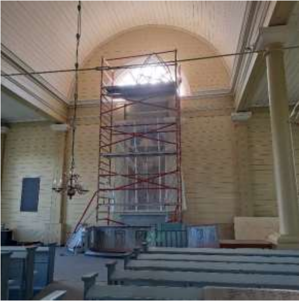
Uuden ikkunan asennus.
