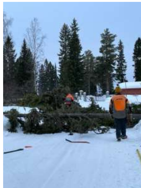
Puiden kaatoa hautausmaalta ja parkkipaikalta.
