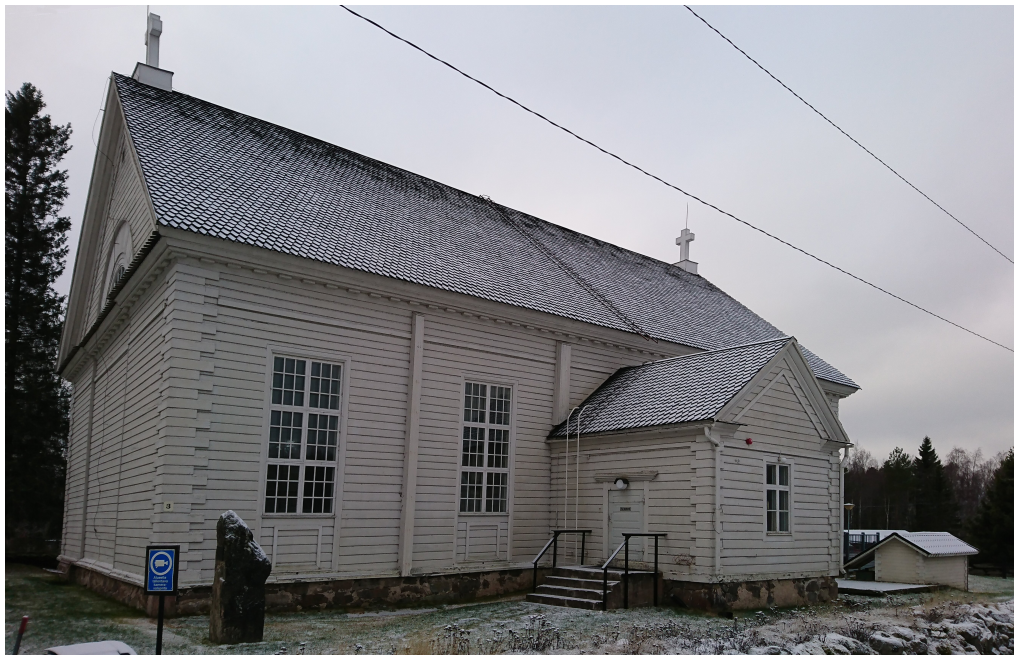
Kirkon pohjoispuoli, sakastin portaissa väliaikaiset kaiteet, kuvattu 10.11.2022
